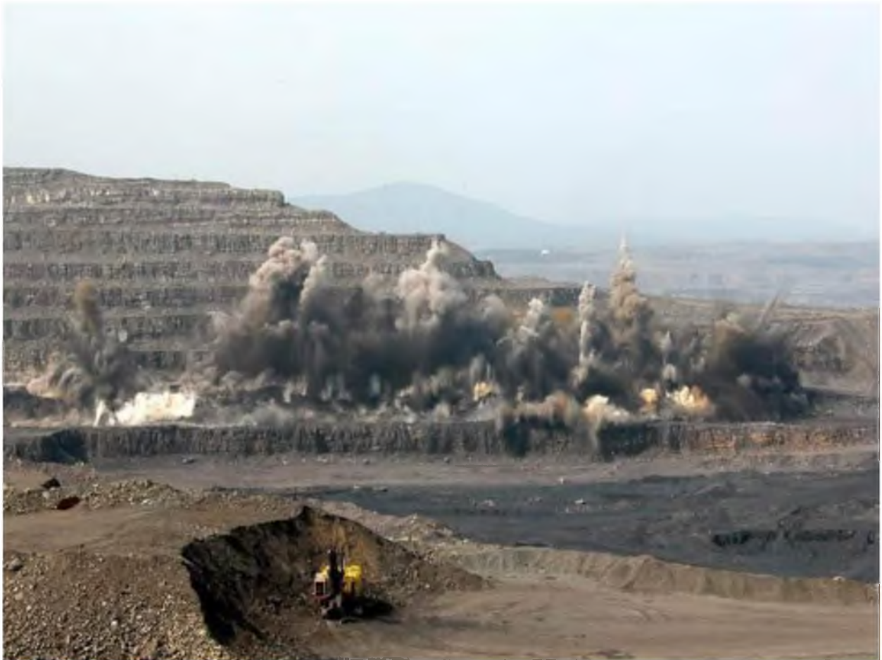
Рисунок 3.10. Взрывные работы на карьере Нерюнгринский
